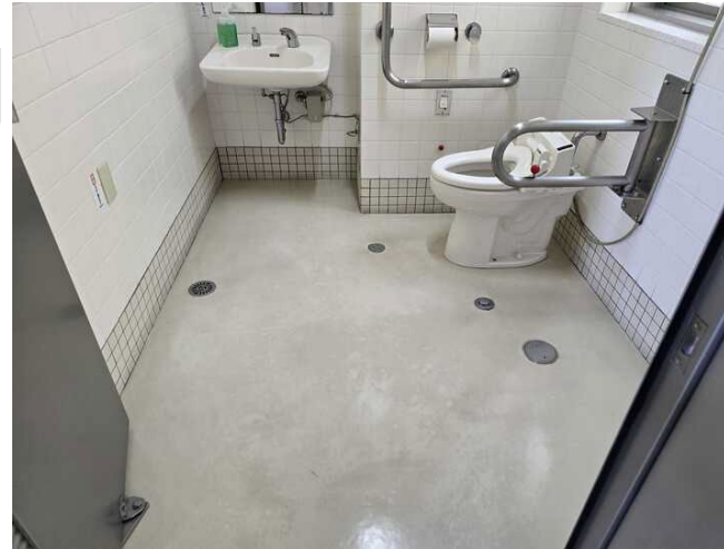
写真 2階みんなのトイレ (おむつ台なし)
